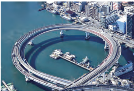
▲道路建設や整備 提供 東京都
